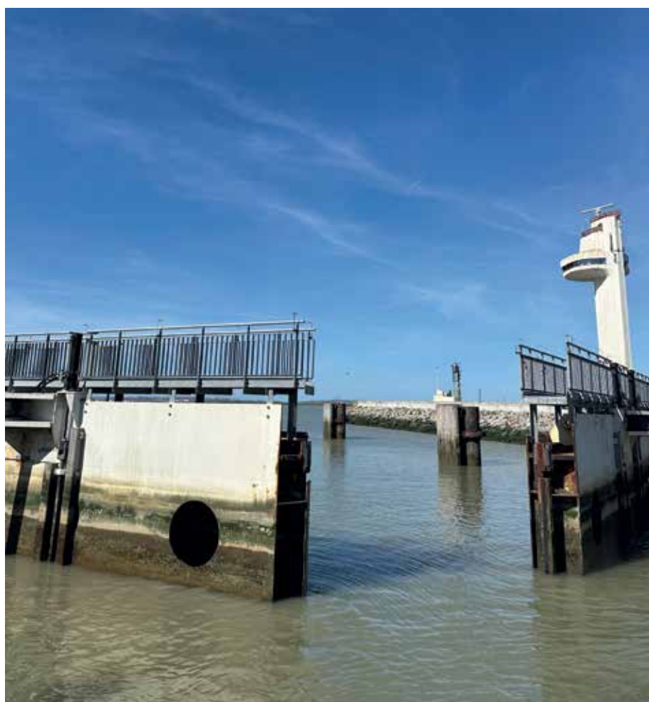
Sustav ustave (écluse) na izlazu iz luke Honfleur prema rijeci Seini. Ovo tehničko rješenje zadržava vodu u lučkom bazenu i omogućuje brodovima nesmetanu plovidbu, neovisno o drastičnim promjenama plime i oseke.
